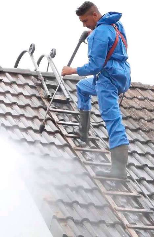
Escada de telhado
